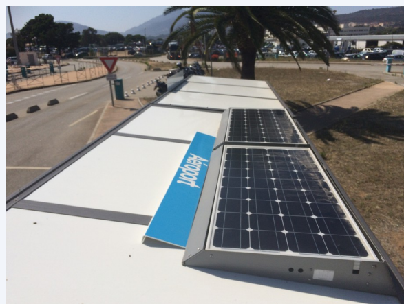
Le kit installé sur la toiture d'un abri
